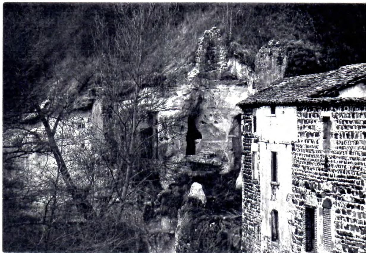
Vestiges d'une habitation troglodyte qui fut une des premières constructions du village, elle est située à l'entrée du bourg en venant de Plauzat.
